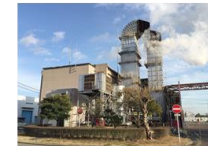
水素発電設備
