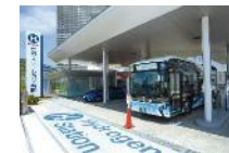
水素ステーション
